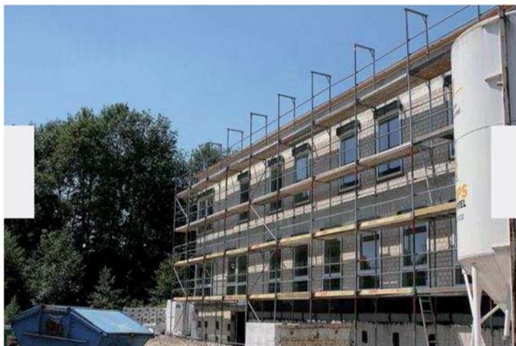
1/2 Der Neubau des St. Marien Hospitals.
